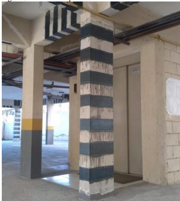
Figura 5 – Pilar reforçado com manta de fibra de carbono.
